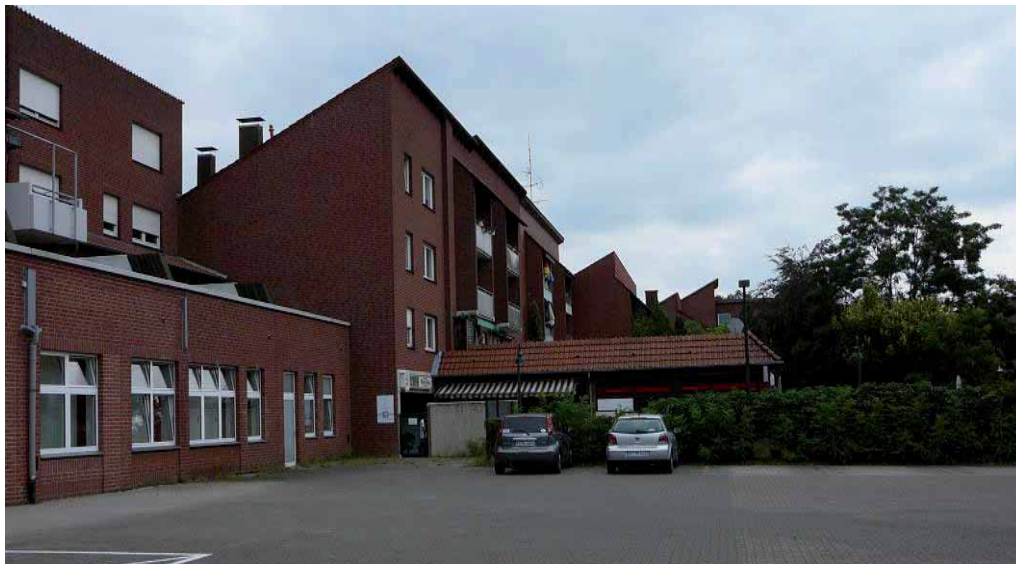
Abb. 29: Blick auf das ehemalige Postgebäude und die Bebauung zwischen Marktplatz und Brinkstraße
