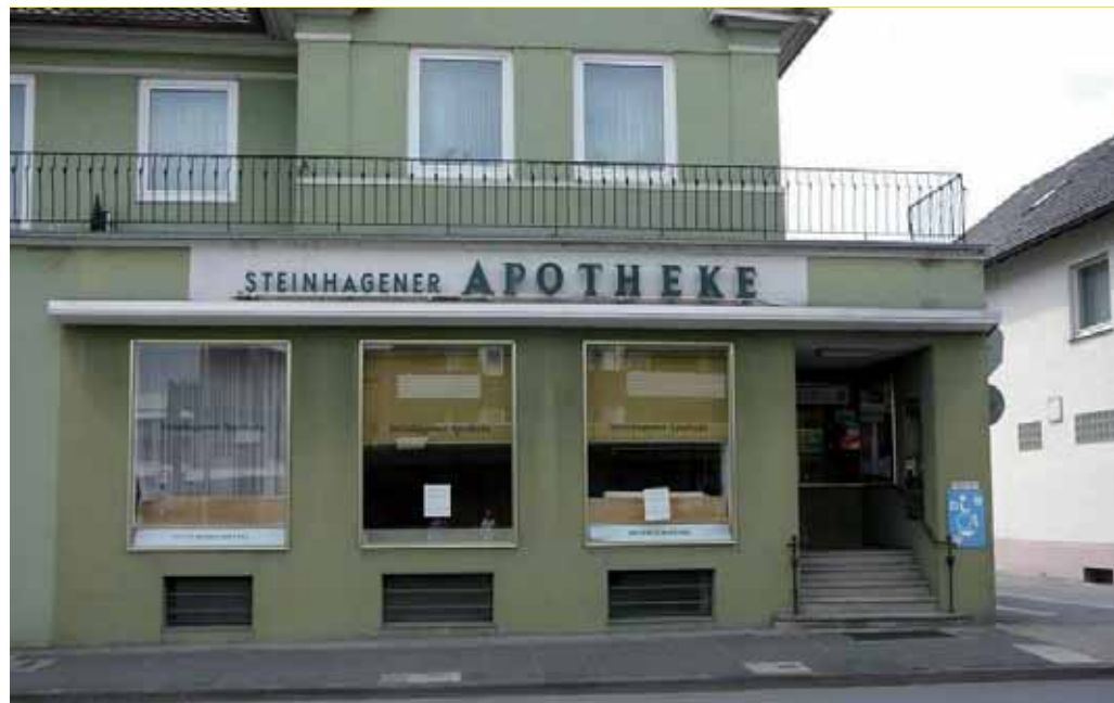
Abb. 20: Leerstehende Apotheke an der Bahnhofstraße
