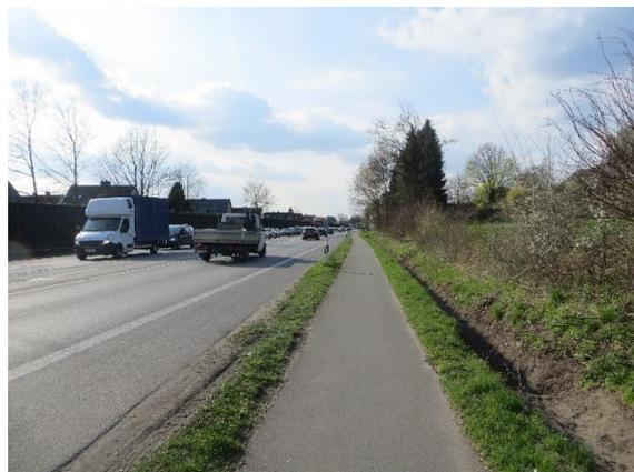
**Planung:** Empfohlen wird das Anlegen von jeweils ERA-regelbreiten Radwegen auf beiden Seiten der Fahrbahn unter Einbeziehung der vorhandenen Mehrzweckstreifen. Der Ausbau sollte in
